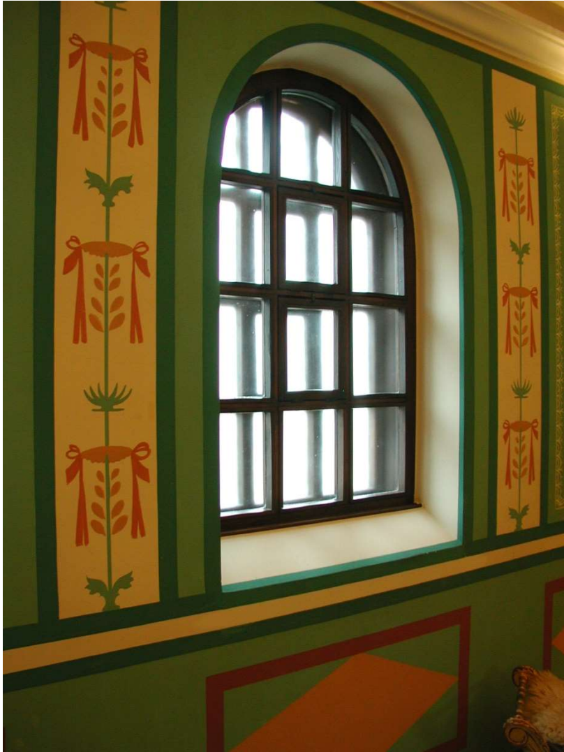
Doppeltverglastes Fenster im Heißbad der Römischen Villa Borg (Foto: I. Vogt).
